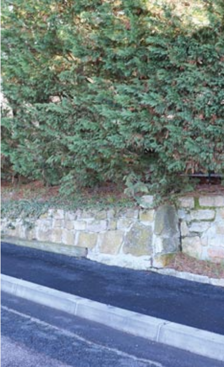
Trottoir route du Bois d'Ars
