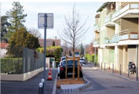
Création d'un massif végétalisé chemin du Bois d'Ars
