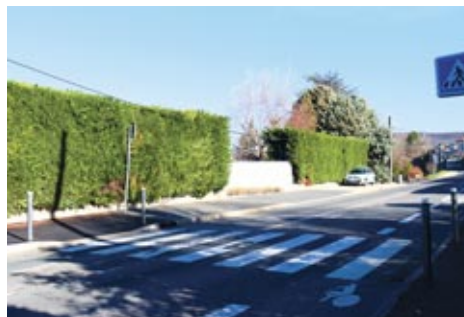
Création et sécurisation d'un passage piéton route de La Garde
