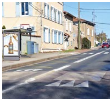
Création de séparateurs route du Puy d'Or
